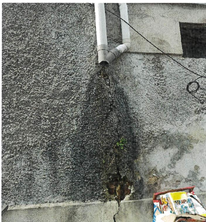
Descente d'eau pluviale non raccordée et parement fissuré
