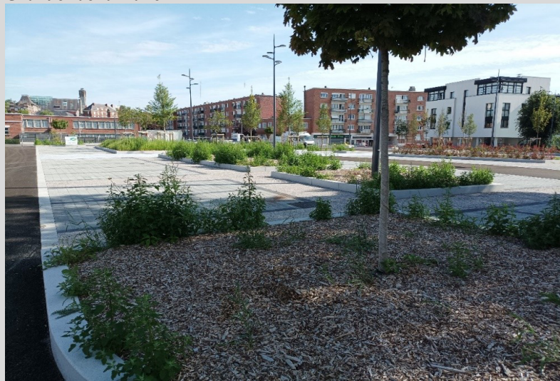
Chantier d'aménagement de la place de Wattignies
