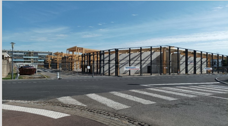
Chantier de la Halle
