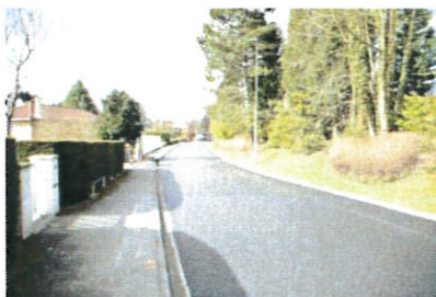
Réfection de voirie effectuée boulevard des Océans
