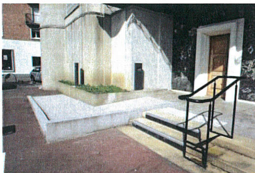
Mise en accessibilité de l'église Saint-Pierre Saint-Paul
