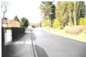
Réfection de voirie effectuée boulevard des Océans
