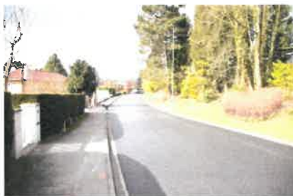
Réfection de voirie effectuée boulevard des Océans
