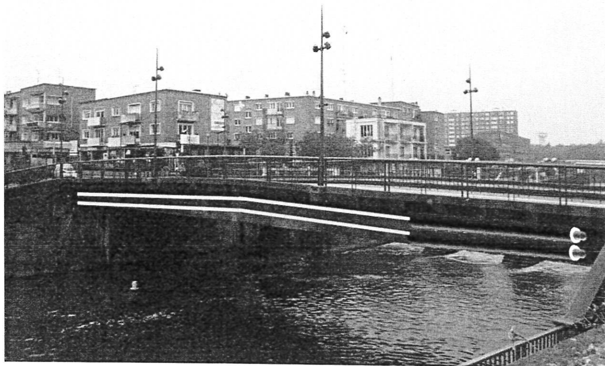
Traversée de la Sambre au niveau de l'avenue de France
